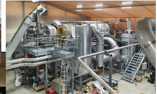
Pyrolyysireaktorin (pyöröuuni, rotary kiln) toimitus sekä pyrolyysilaitteiston asennuksen tilanne 7.10. 2020. Laitostoimittaja TECAM Soluciones Medioambientales S.L.
